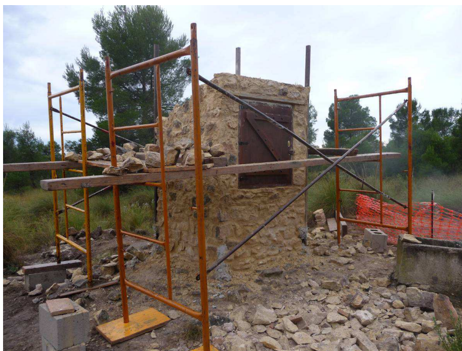
Foto 2. Aljibe del Tollo. Reconstrucción de la capilla del aljibe. Fecha: 22.12.2010
