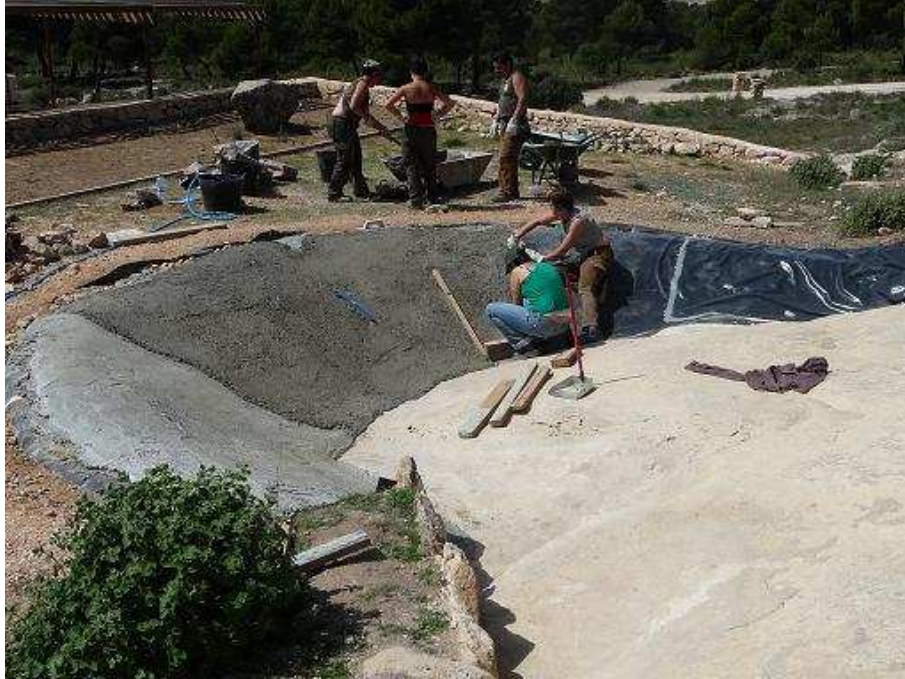
Foto 5. Charca de la Casa del Guarda. Fase de construcción (impermeabilización). Fecha: 7.4.2011
