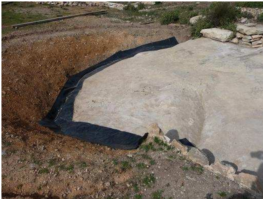
Foto 4. Charca de la Casa del Guarda. Fase de construcción (excavación). Fecha: 7.4.2011
