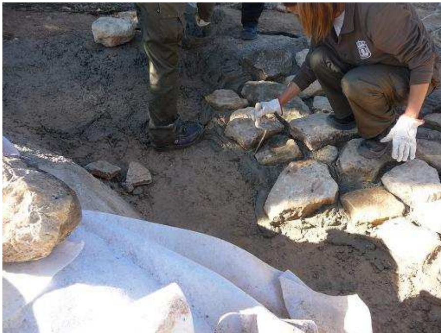
Foto 2. Charca del Arabilejo. Fase de construcción (detalle).
