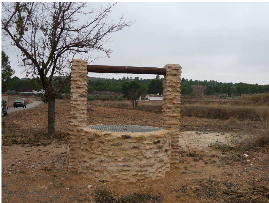
Foto 8. Pozo concejal de la Fuenteálamo. Fase final.
