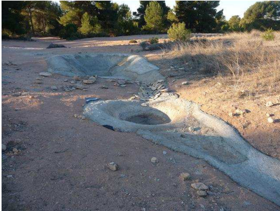
Foto 3. Charca de la solana del Arabí. Fase de construcción.
