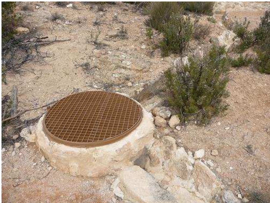
Foto 6. Aljibe de la Cueva del Patriarca. Restauración e instalación de rejillas para eliminación de peligrosidad a personas y animales. Fase final.
