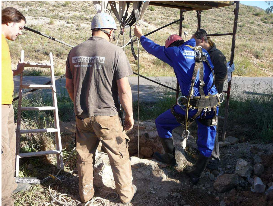
Foto 7. Pozo concejal de la Fuenteálamo. Trabajos de limpieza.
