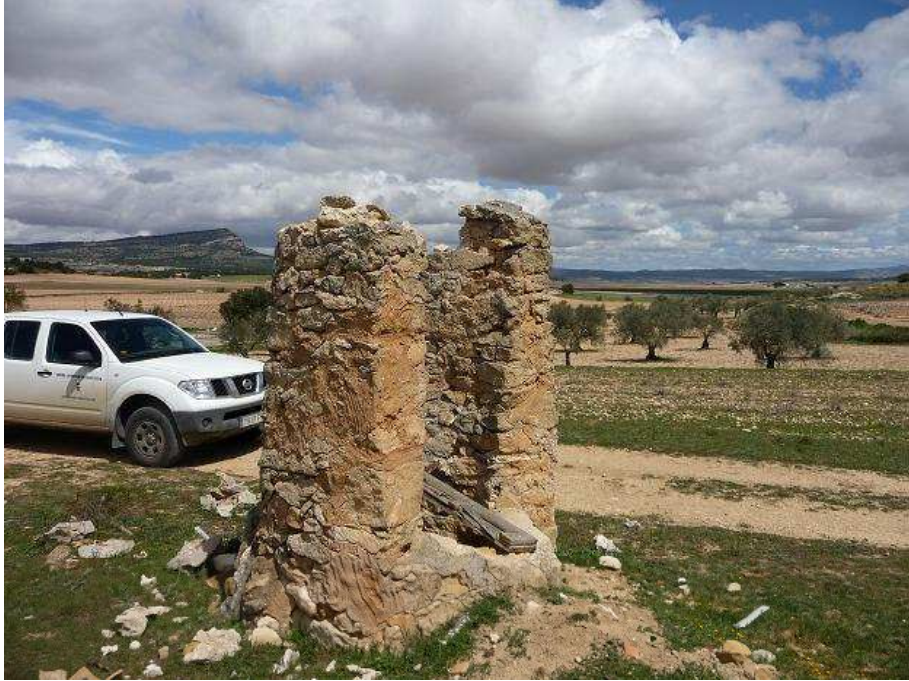
Foto 1. Pozo concejil de la Mina Tárraga. Fase previa.
