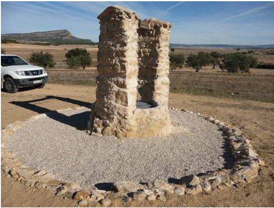
Foto 2. Pozo concejil de la Mina Tárraga. Fase final.
